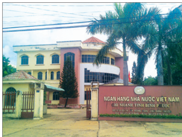
Trụ sở Ngân hàng Nhà nước Việt Nam - Chi nhánh tỉnh Bình Phước
